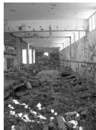
Fig. 3 – interior, 2º andar
